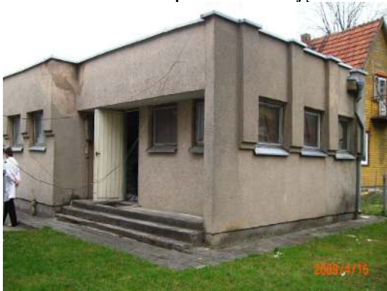
Pastatas prieš rekonstrukciją
